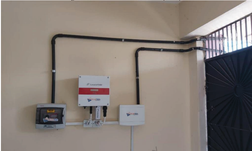
Figura 5.5 – Inversor e sistema de proteção
