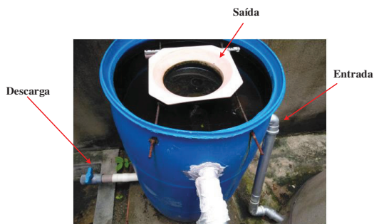
Figura 4.3 – Decantador do tipo cilíndrico ligado ao tanque de criação dos peixes
